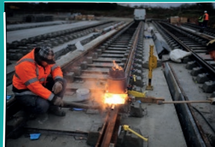
Soudure de rail chantier ligne A
